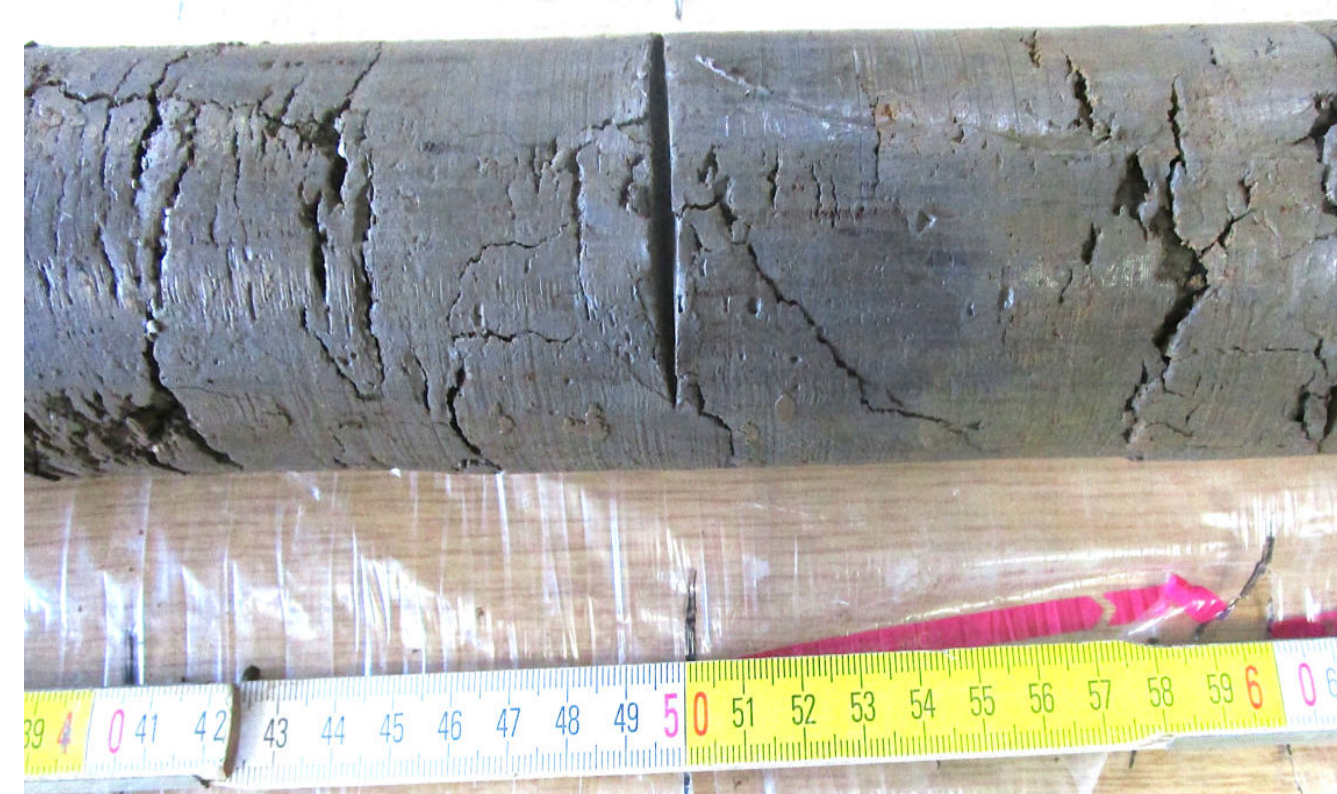
Abb. 2: Bohrkern unterteilt in zwei 10 cm Abschnitte.
