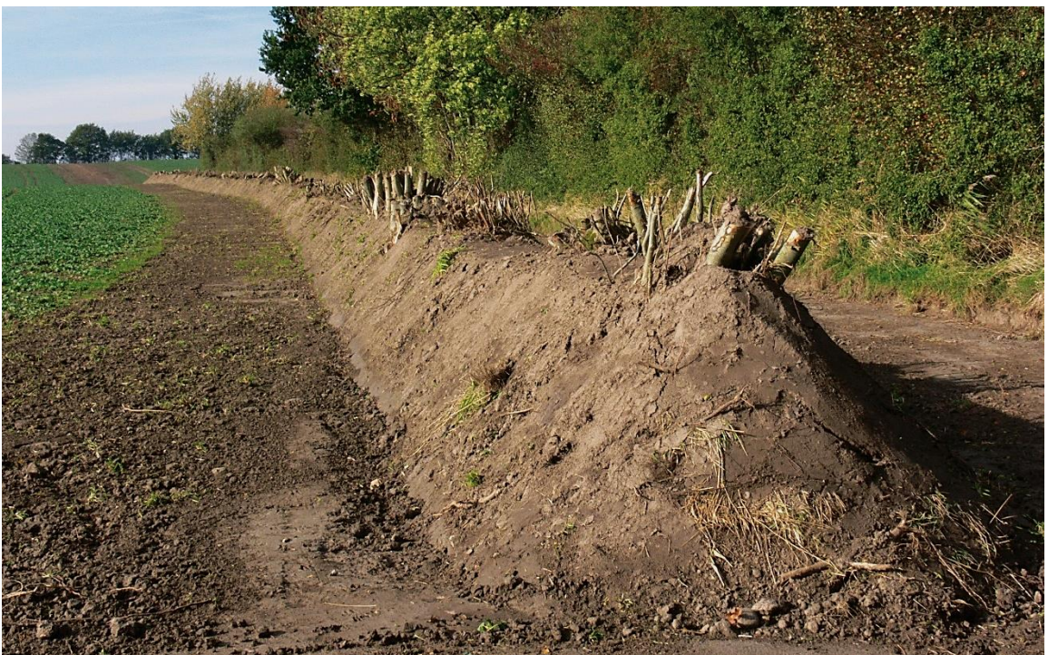
Versetzter Knick, aufgebaut aus dem Material einer anderorts beseitigten Wallhecke Foto: Henning Thiessen
