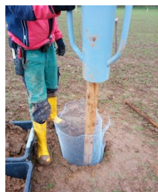
Abb. 2: Wühlmausdraht und Pfahl mit Pfahlramme (Quelle: eigene Aufnahme, Nov. 2022)
