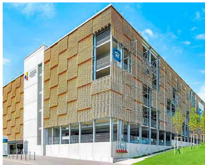
Abb. 3: Robinienleisten sind gut geeignet zur Verschalung von Fassaden, hier am Parkhaus des Universitätsklinikums Tübingen.
