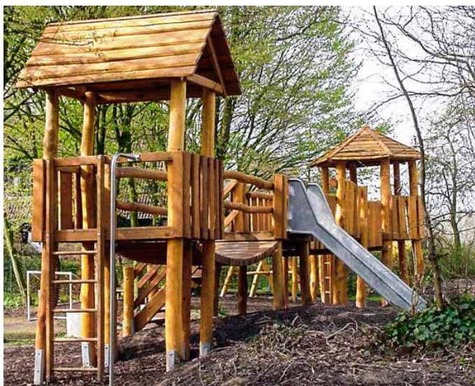
Abb. 2: Die Kombination aus hoher mechanischer Festigkeit und natürlicher Dauerhaftigkeit macht das Holz der Robinie ideal geeignet für Spielplätze und -geräte.
