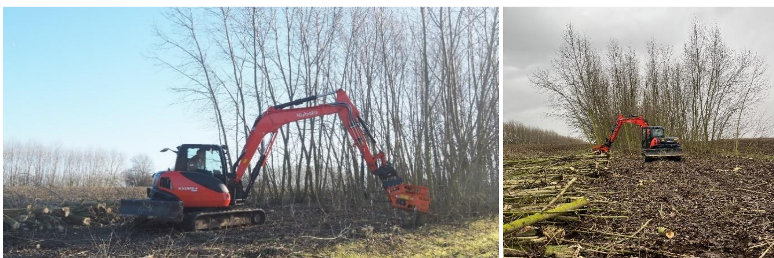
Abb.2: Fällarbeiten wurden mit Bagger (Reichweite 7,3 m) und Schneidgreifer durchgeführt.
